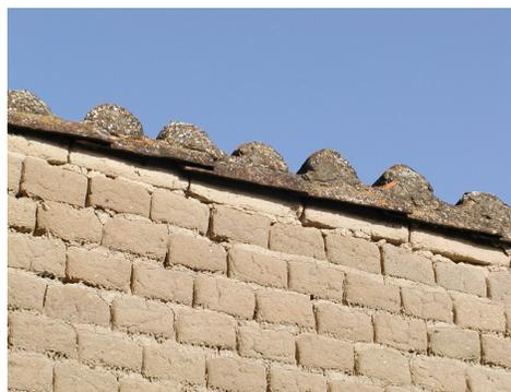
**Particolari delle murature in terra cruda nurachesi, la disposizione del mattone (*ladrini*) è del tipo a due teste. Non sono state riscontrate apparecchiature a tre teste.**
