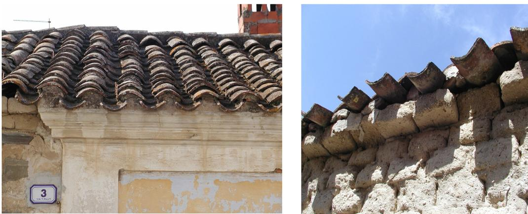
Esempi di copertura e di gronda del tipo con tegole in aggetto su cornice modanata (si veda abaco tipologico)
